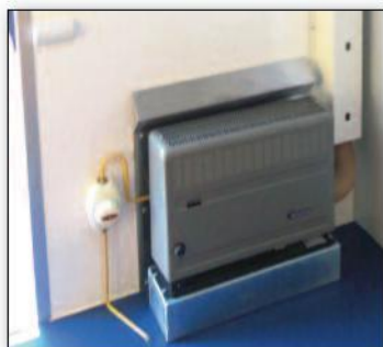
Radiateur gaz. et vanne de sécurité gaz.
