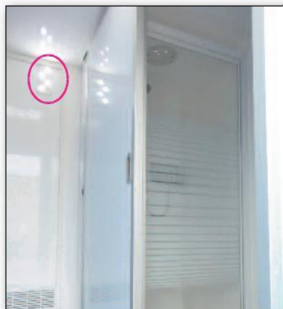
Éclairage par leds 12 volts et interrupteur temporisé.
