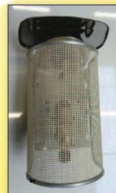
Éclairage gaz sécurité.
