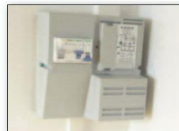
Chargeur BIP. Tableau électrique + transformateur 12/220 volts.
