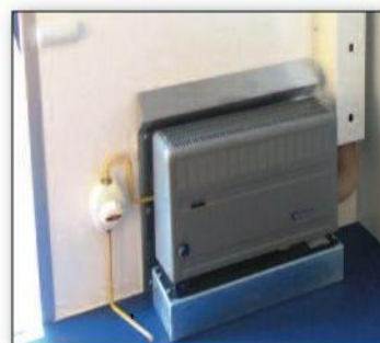
Radiateur gaz. et vanne de sécurité gaz.
